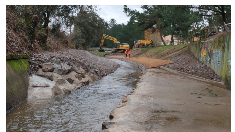
Ci-dessus, les travaux de la rigole des Anglais avant et après les travaux. Les structures en béton ont été supprimées et le ruisseau a repris son cours d'origine.
