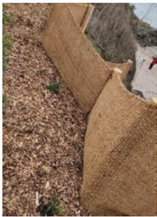
traverse, ce qui a deux effets bénéfiques : une diminution de l'érosion due au vent et un dépôt du sable transporté au pied de la toile. Ces ouvrages souples et réversibles limitent l'érosion, contrairement aux enrochements qui la reportent sur les zones adjacentes. La finalisation de ces travaux par Pornic Agglo Pays de Retz nous a permis de remettre la clôture de protection en bois afin d'assurer la sécurité des personnes.
