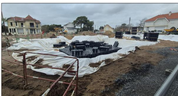
La pose de bacs de rétention et d'infiltration permet aux eaux pluviales d'être réabsorbées par la terre et d'éviter ainsi les ruissellements de surface.
