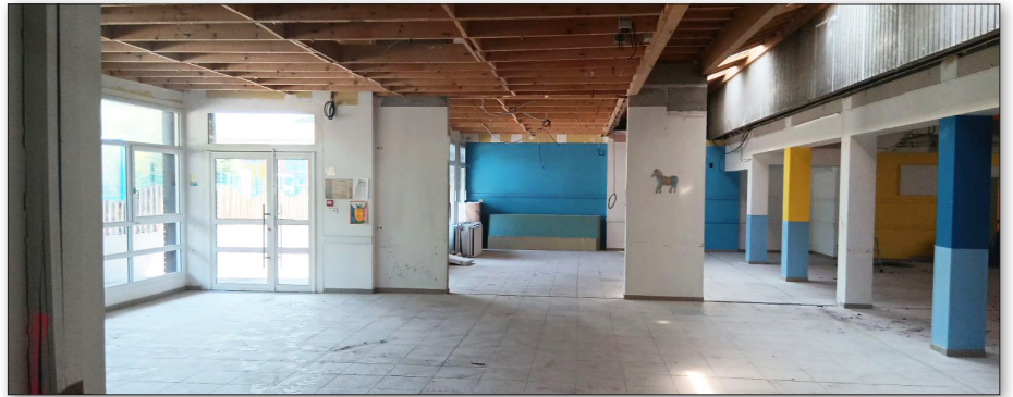
Ci-dessus, le restaurant scolaire en travaux.
